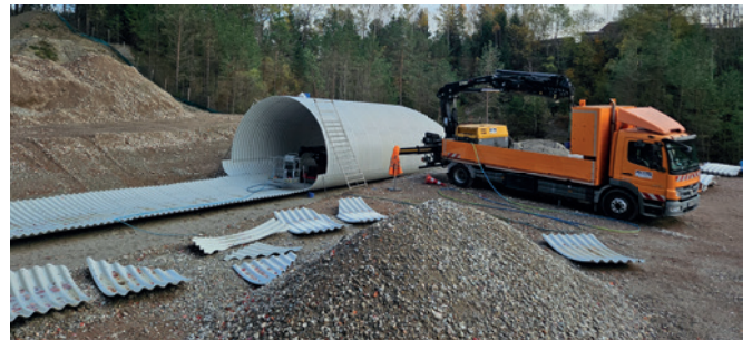
Montage eines Durchlasses außerhalb der Baugrube
