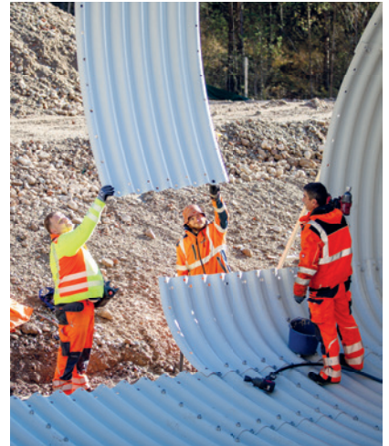
Verbauen des Multiplate-Systems
