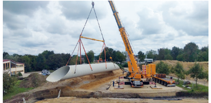
Einsetzen eines Durchlasses mit dem Autokran
